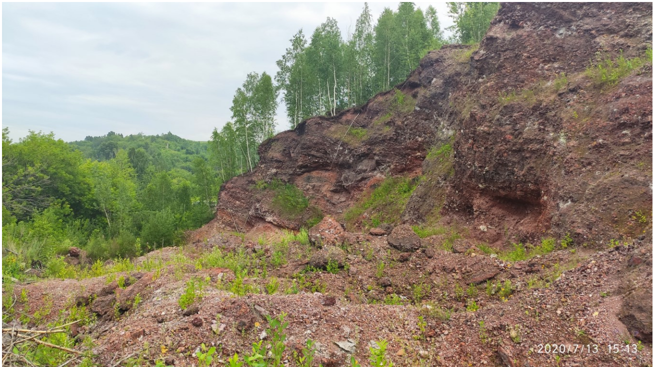
Рис. 2. Поверхность породного отвала по ул. Новостройка
