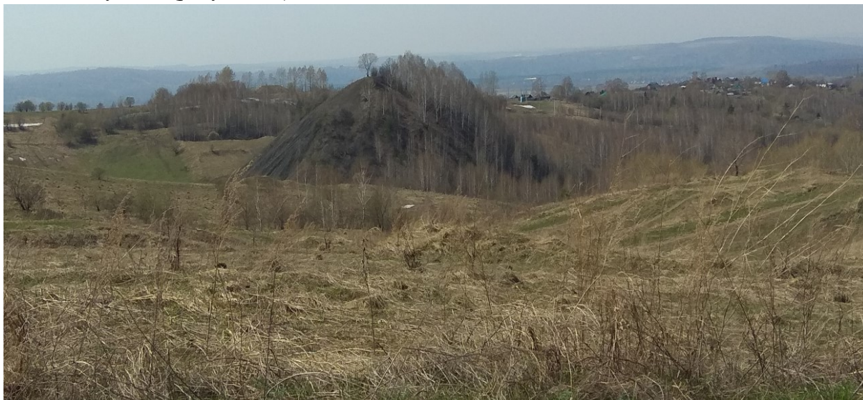
Рис. 33. Общий вид в районе отвала по ул. Шахтёрская
