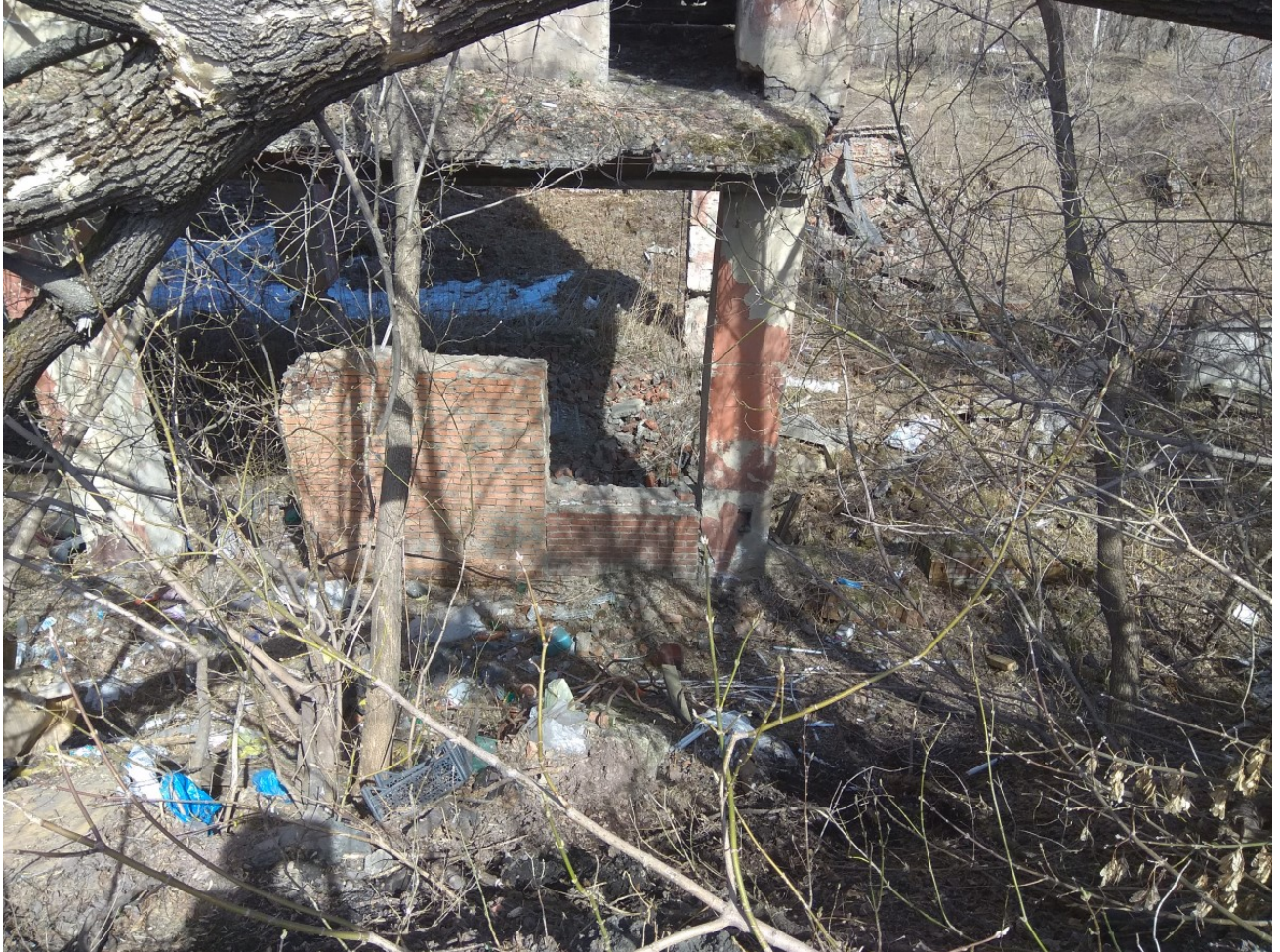
Рис. 23. Вид участок и здание на здание погрузки по ул. 9-я Штольня д. 18/2
