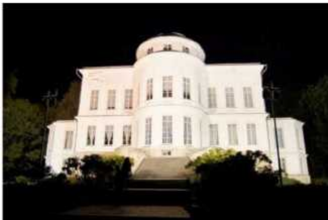
Здание, расположенное в зоне охраны объектов культурного наследия
