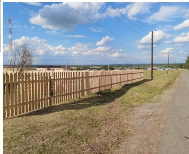
Дорожное ограждение Прокопьевский район ФКУ ЛИУ-16
